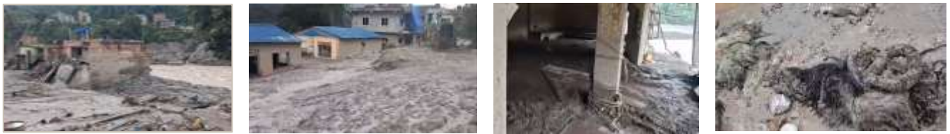
▲ 土石流で被災した市街地の様子（ビドウル市／現地パートナー撮影）。川沿いの建物は、被害も大きく、2F以上の部屋にも土砂が堆積、流れ着いた水牛の死骸も…
